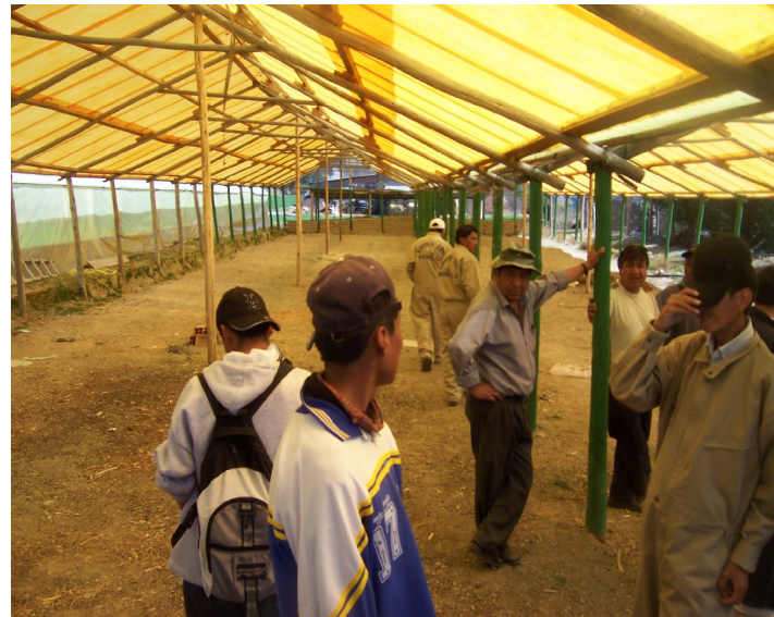
Carpa de doble callapos en la etapa final (vista exterior e interior).
